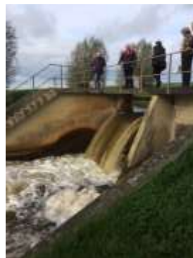
De waterinlaat aan de Noordermeerdijk
